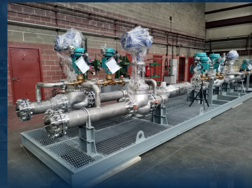
Блок КРП на сборочной площадке ООО «РусГазКрио»
