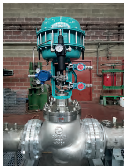
Рис. 4. Седельный клапан на нитке кислородно-распределительного пункта
